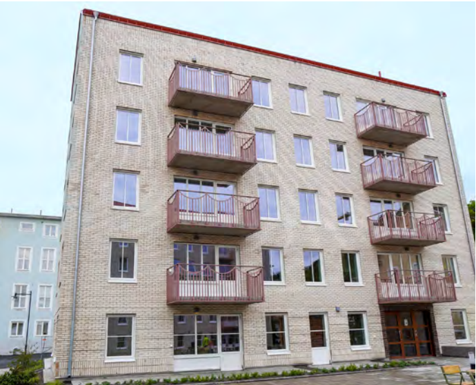
FJÄLLBO PARK Vid foten av Utbybergen med den grönskande parken runtomkring står tre nya hus med totalt 75 lägenheter.
